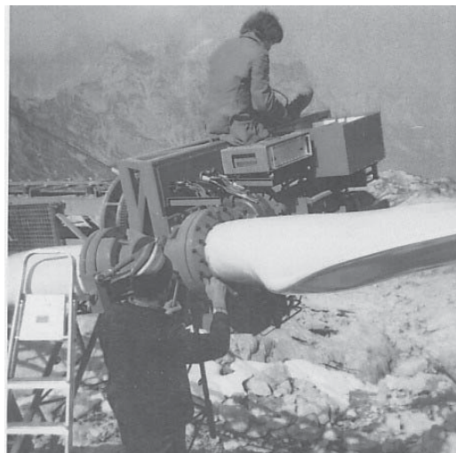
Rotormontage am Generator Quelle: Geschichtclub Stahl
