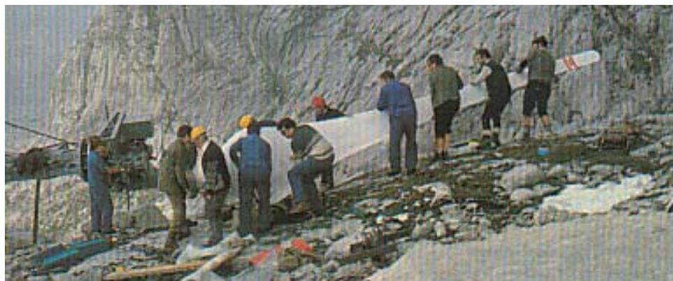
Montage eines der Rotoren mit 9 Meter Länge durch OKA- Monteure Quelle: Archiv Grettl Urstöger
