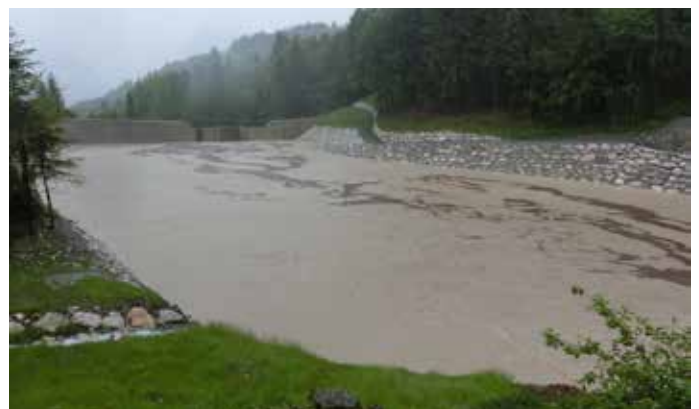
Hochwasserrückhaltebecken mit Teileinstau 2. Juni 2013
