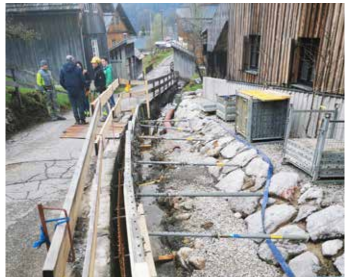
Vor den Altbestand wird nun eine neue Mauer vorgesetzt.
