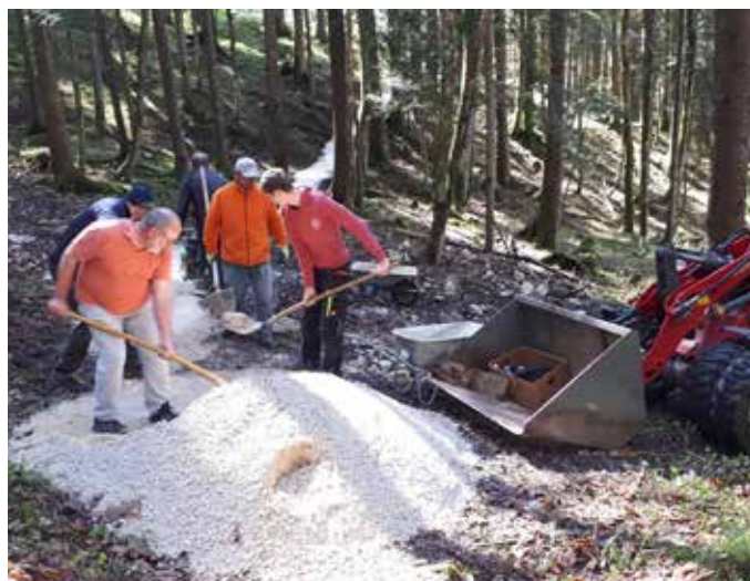
Arnethweg Wildfütterung bis Kalvarienberg: Teile neu eingeschottert, Stufen erneuert. Alexander Kalss, Hans Kainzinger, Benedikt Winkler, Stefan Pucher, Thomas Goertz.
