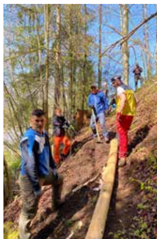
Plattenkogelweg: Wegestücke verbreitert, Wegeränder mit Rundhölzern befestigt.
