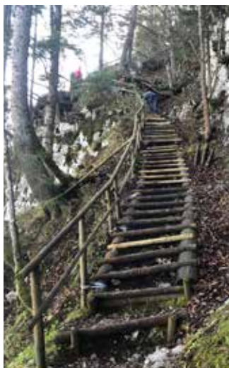
Tressensattelsteig: Stufen Instand gesetzt, Geländer repariert.
