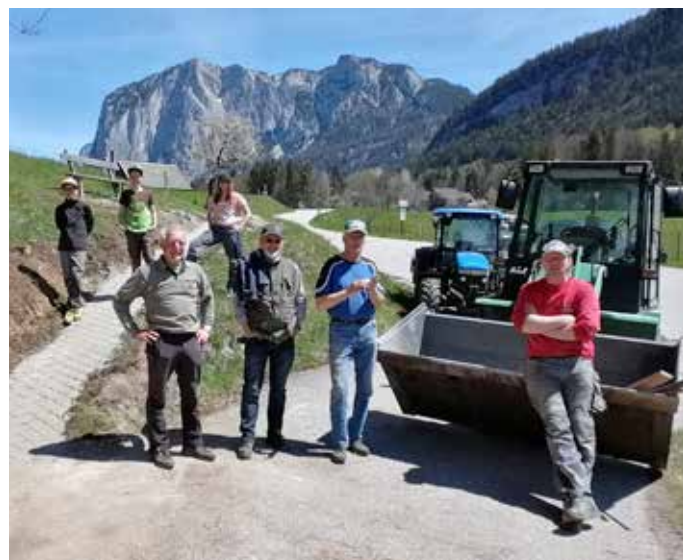
Arzleiten: Wege eingeschottert, bei Bankerl Hundskogel Pflastersteine verlegt. Stefan Temmel, Alois Köberl, Rainer Seethaler, Sepp Grill, Luki Grill, Gunter Khälß, Armin Khälß, Emely Temel.
