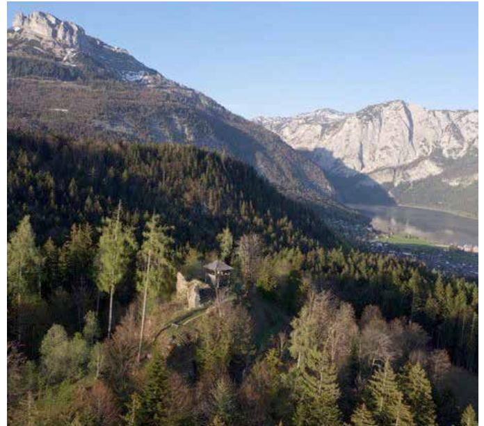
Die Reste der Burgruine sollen erhalten und gesichert werden.
