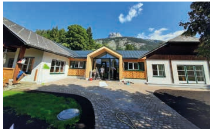
Der neue Eingang ist barrierefrei.
