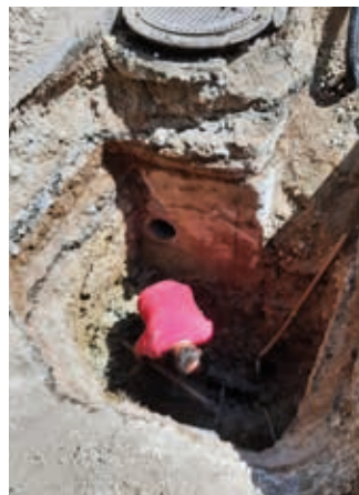
Sehr aufwendig – der Kanalanschluss in ca. 4,5 Metern Tiefe.
