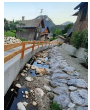
Neues Brückengeländer im Nagerldorf
