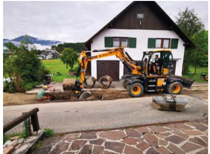
Die gesamte Verrohrung wurde erneuert.
