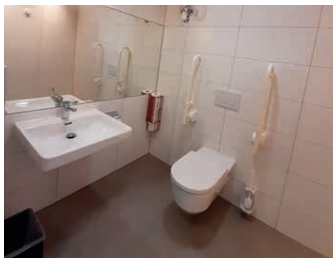
Auch über die Sommermonate entstanden: das behindertengerechte WC an der VS Altaussee.
