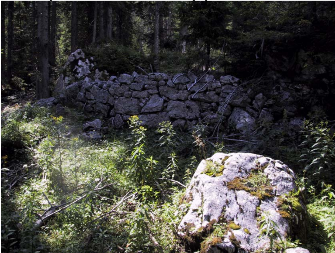
Steinmauer als Schutz vor dem Versturz westlich des Trepfels der ehemaligen Hüpflingeralm
