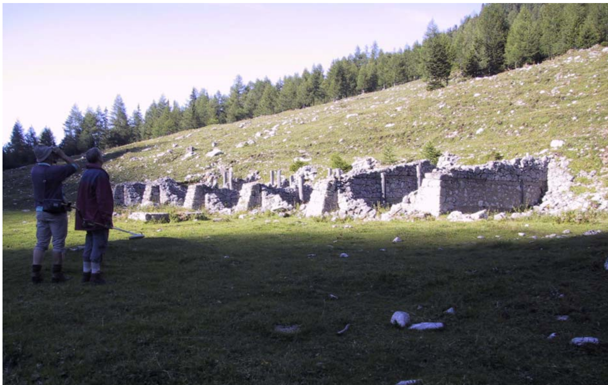
Der Blick vom Alpstall hinauf zur Anschüttung der Lugauer-Plan-Lawine dokumentiert den schlecht gewählten Bauplatz.
