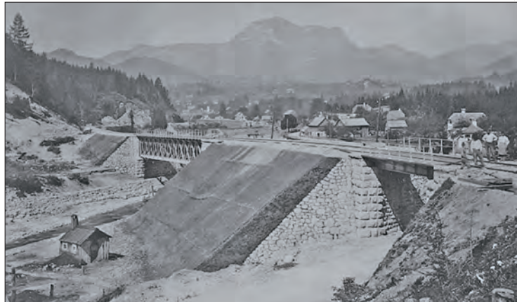
In Unterkainisch nahe des sogenannten „Zwoanzgers“ musste die Kainischtraun überbrückt werden.
