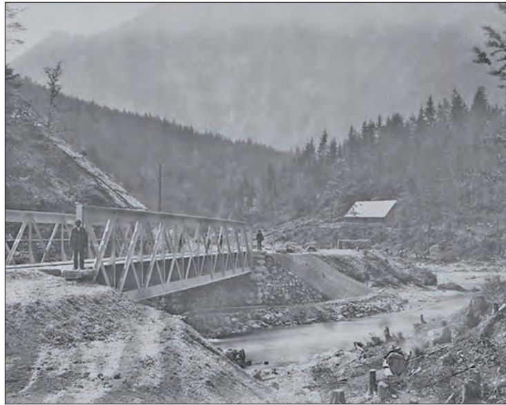
Die Brücke über die Koppentraun bei Bahnkilometer 329.
