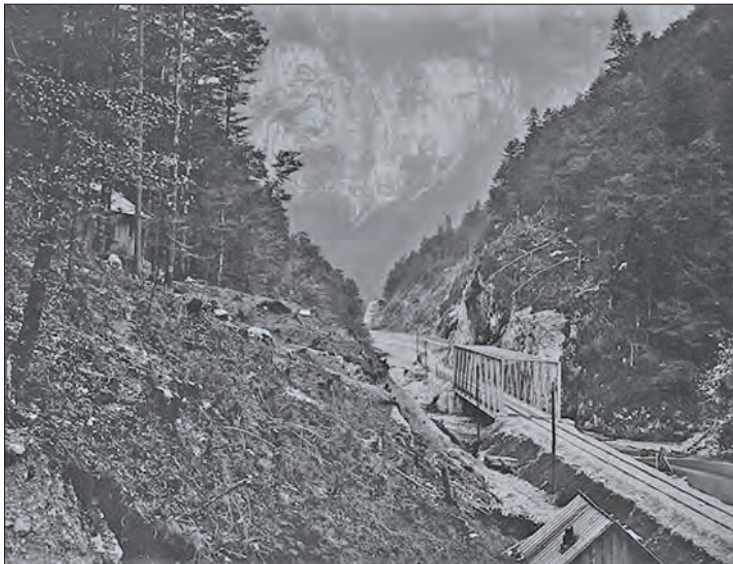
Die Traunbrücke bei KM 360.
